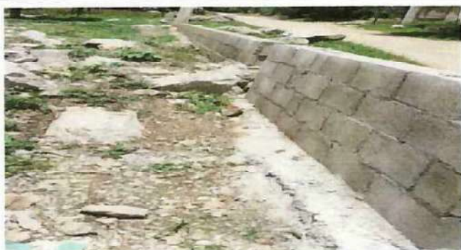
CONTINUACION DE MURO PERIMETRAL.
