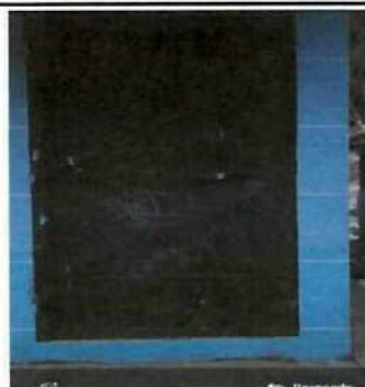
MANTENIMIENTO DE PUERTAS.
